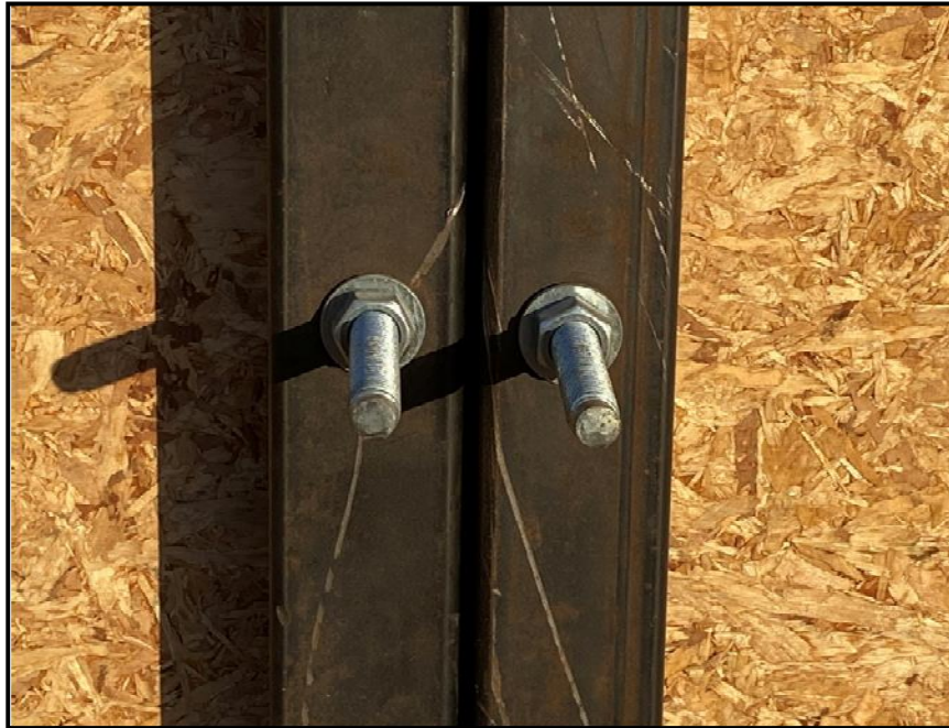
Figura N°5: Anclaje de Pantallas Acústicas, Sector Maestranza.
